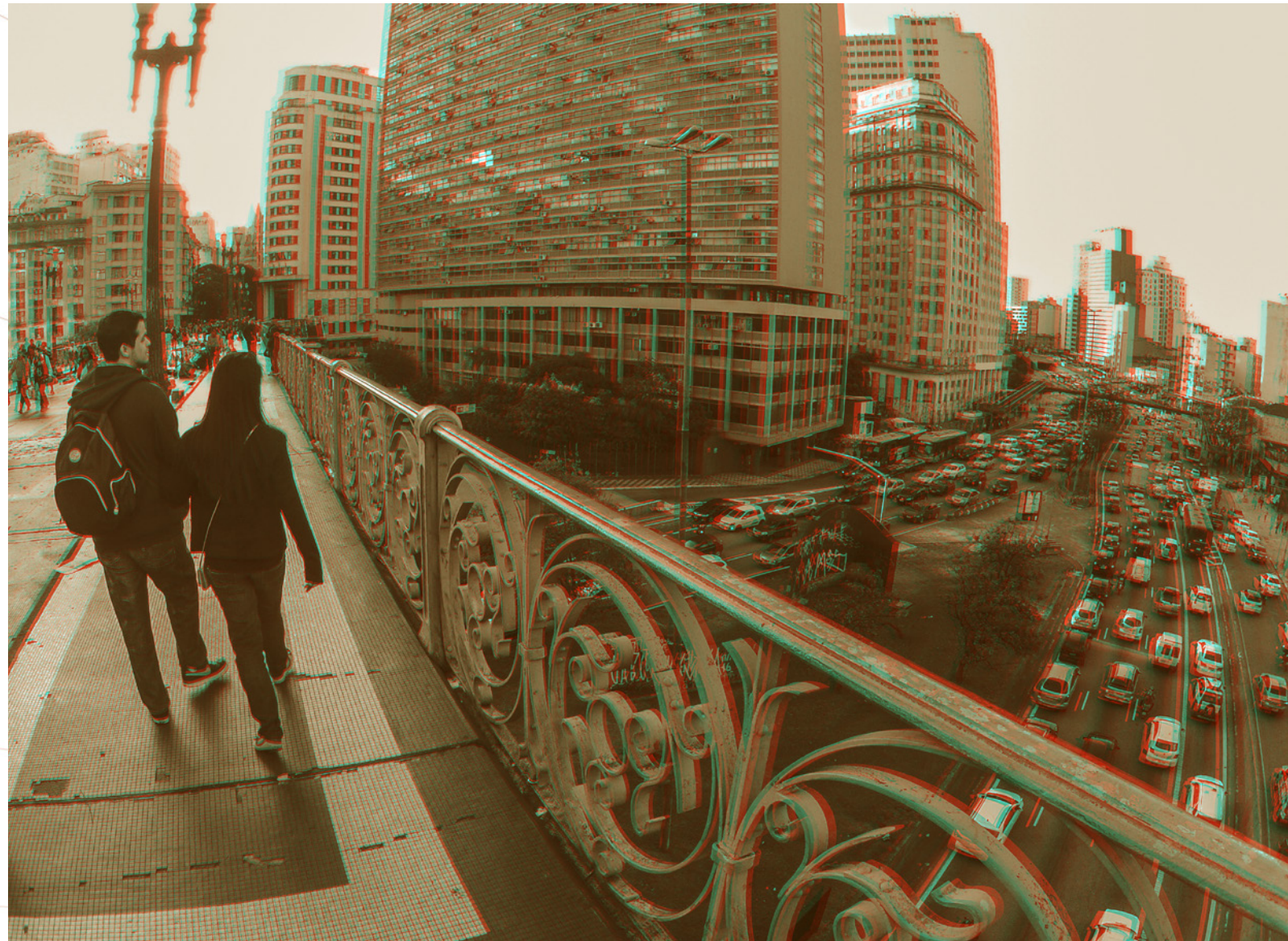
Viaduto Santa Ifigênia
